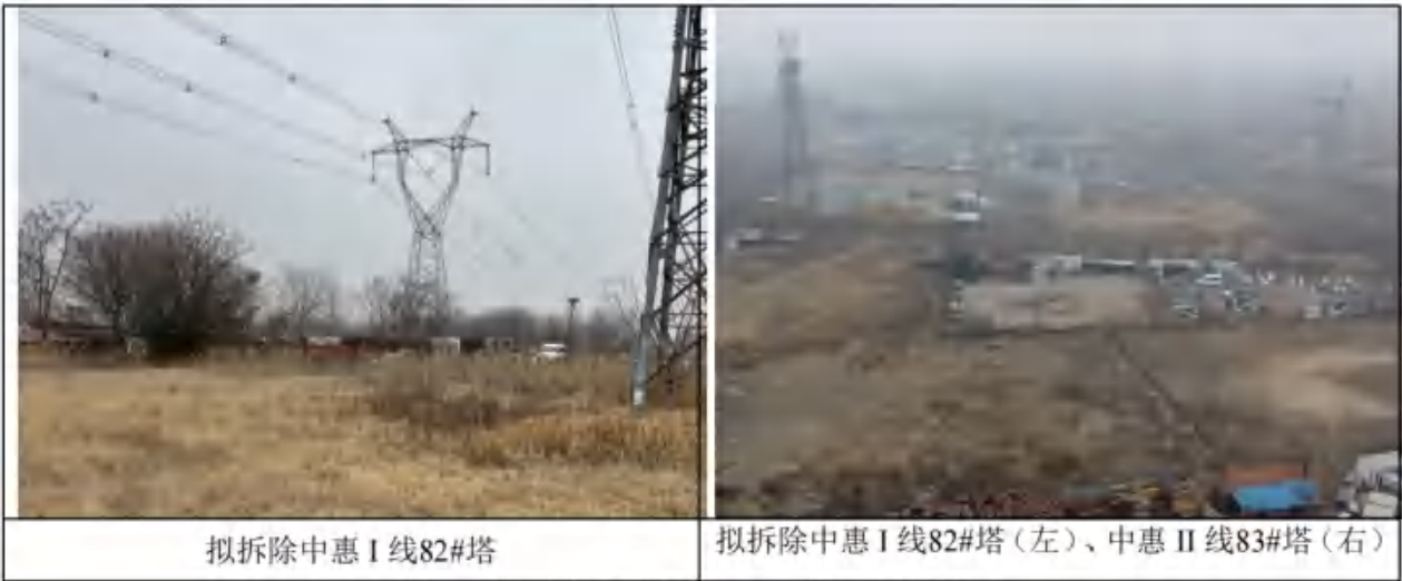
图3-9本项目拟拆除500kV 杆塔现状照片
