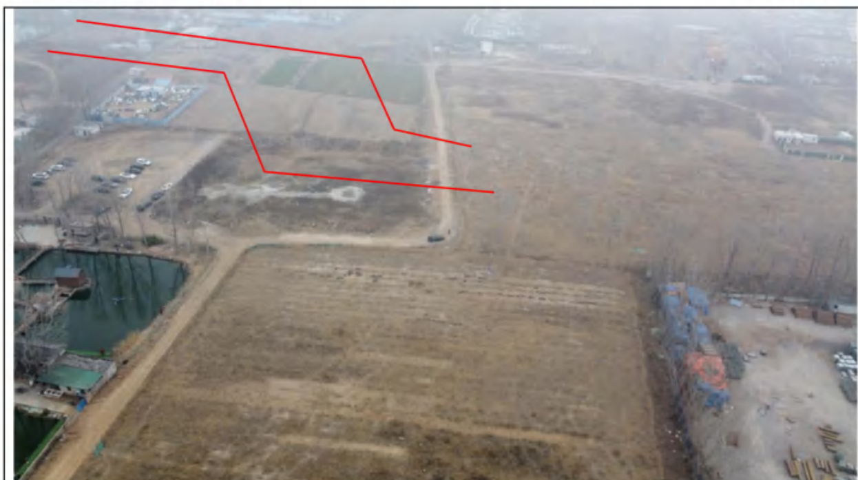
线路沿线现状（至惠济变方向）
