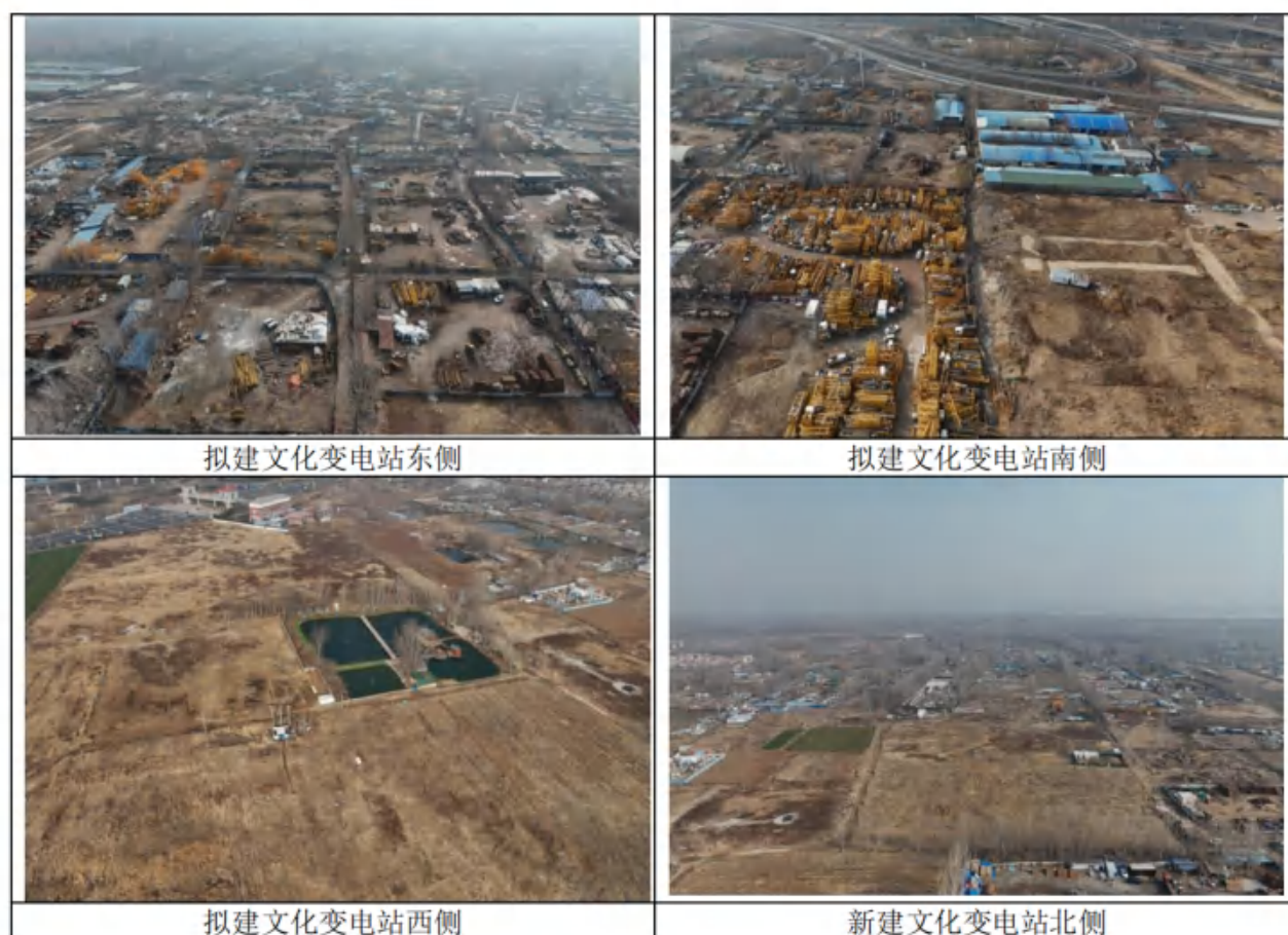
图3-3拟建文化500kV 变电站周边环境情况
